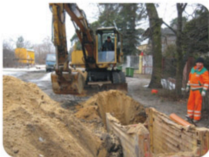
Prace, ul. Torowa, marzec 2010
