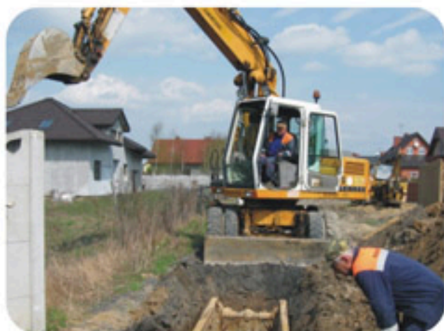
Budowa kanalizacji w Woli Łaskiej, kwiecień 2010
