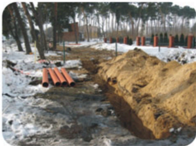
Kanalizacja Orchów, luty 2010
