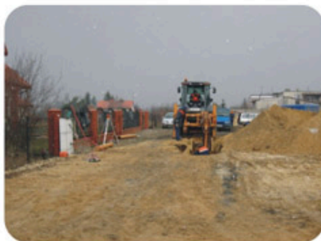
Kanalizacja Wola Łaska, marzec 2010
