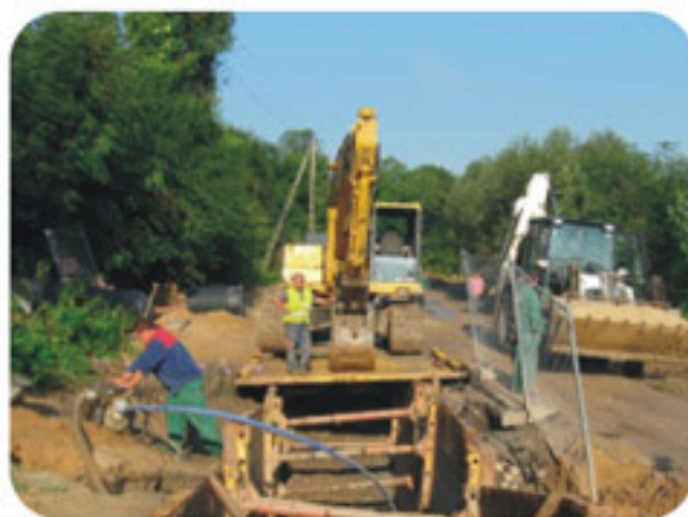
Prace, na ul. Kilińskiego, sierpień 2010
