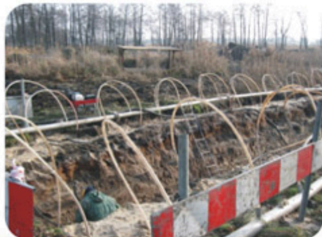
Budowa kanalizacji przy trasie nr 14, grudzień 2009
